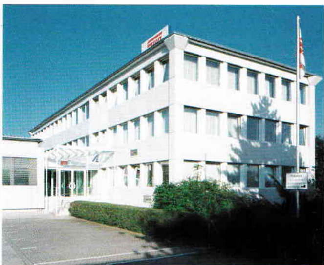
SUN Zentrale in Mettmann
